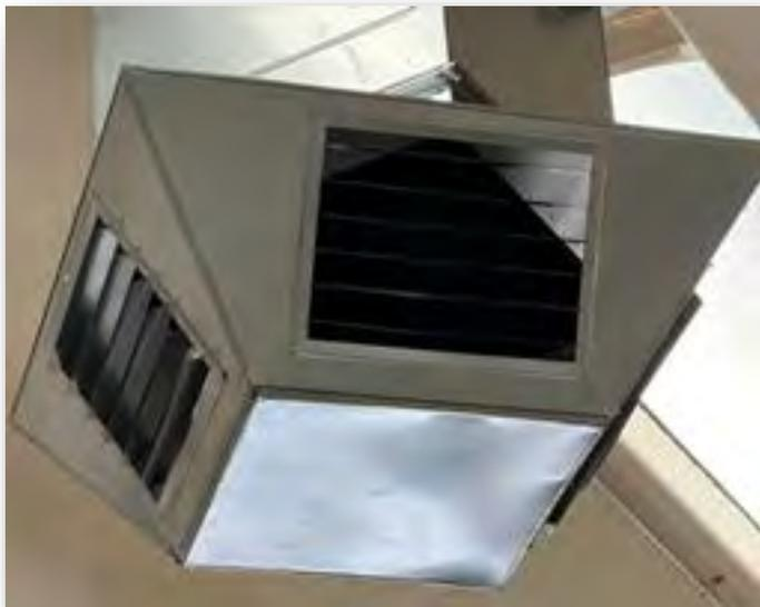
Al termine dell'installazione, sarà possibile regolare le alette presenti sulla parte terminale dei condotti di canalizzazione, così da ottimizzarne la direzione.
